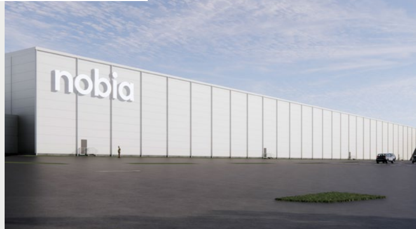
Produktionsanläggning för kök i Jönköping, 125 000 kvm. Beställare: Nobia
